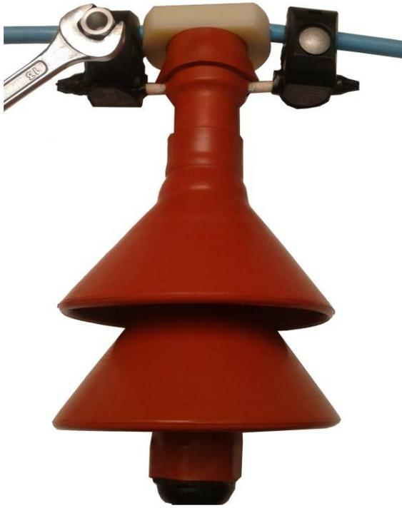
Рисунок 26 – Монтаж блока защитного на ВЛ
