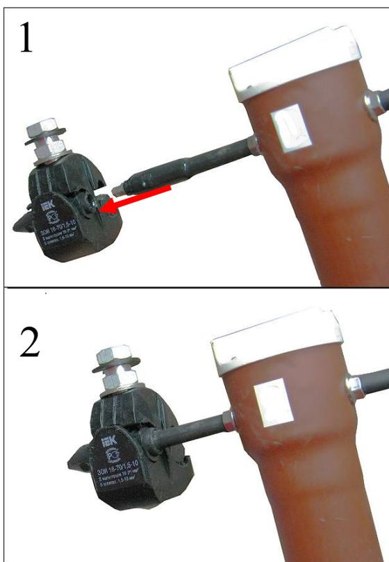
Рисунок 25 – Установка зажима прокалывающего
